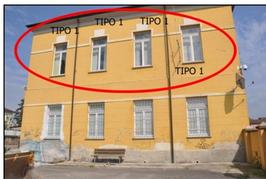
Figura 16 Facciata ovest: serramenti da sostituire (tipo 1)
