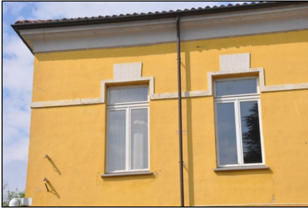
Elemento 0: Nuovi serramenti al piano primo del municipio: serramenti in legno verniciato bianco uguali a quelli esistenti
