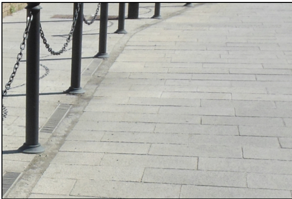
Elemento 12 Pavimentazione marciapiedi e piazza: lastre di pietra (granito bianco cm 30 x 60). Cordoli stradali in granito bianco. Rigature dei riquadri della piazza con binderi o cubetti di granito sempre bianco (larghezza cm 15)
