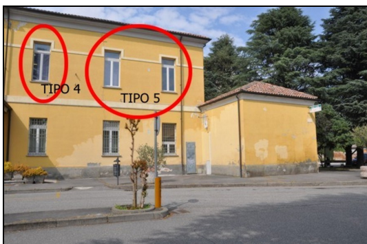
Figura 13 Facciata sud: serramenti da sostituire (tipo 4 e tipo 5)
