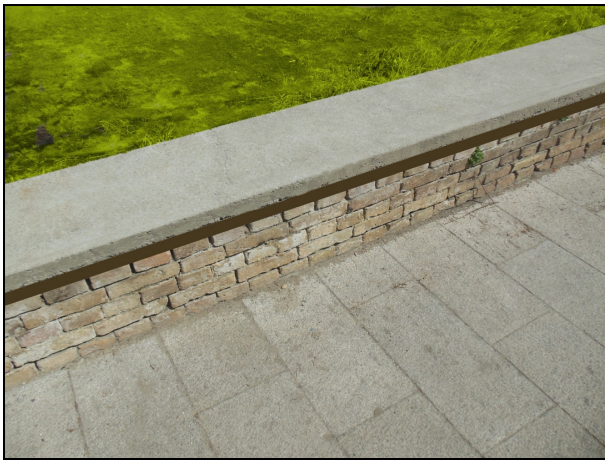
Elemento 4 Muretti di separazione tra piazza e giardino, altezza cm 40, in mattoni pieni vecchi di recupero, a due teste, con copertina di pietra serena
