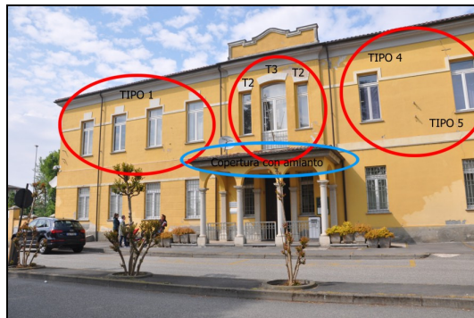
Figura 12 Facciata sud: serramenti da sostituire (tipo 1, 2, 3, 4, 5)
